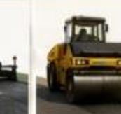
Compactare și finisare
