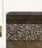
Fundație strat 1 piatră – 25 cm
